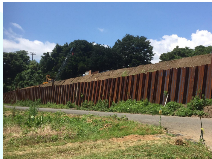
東富岡611の盛り土の状況
